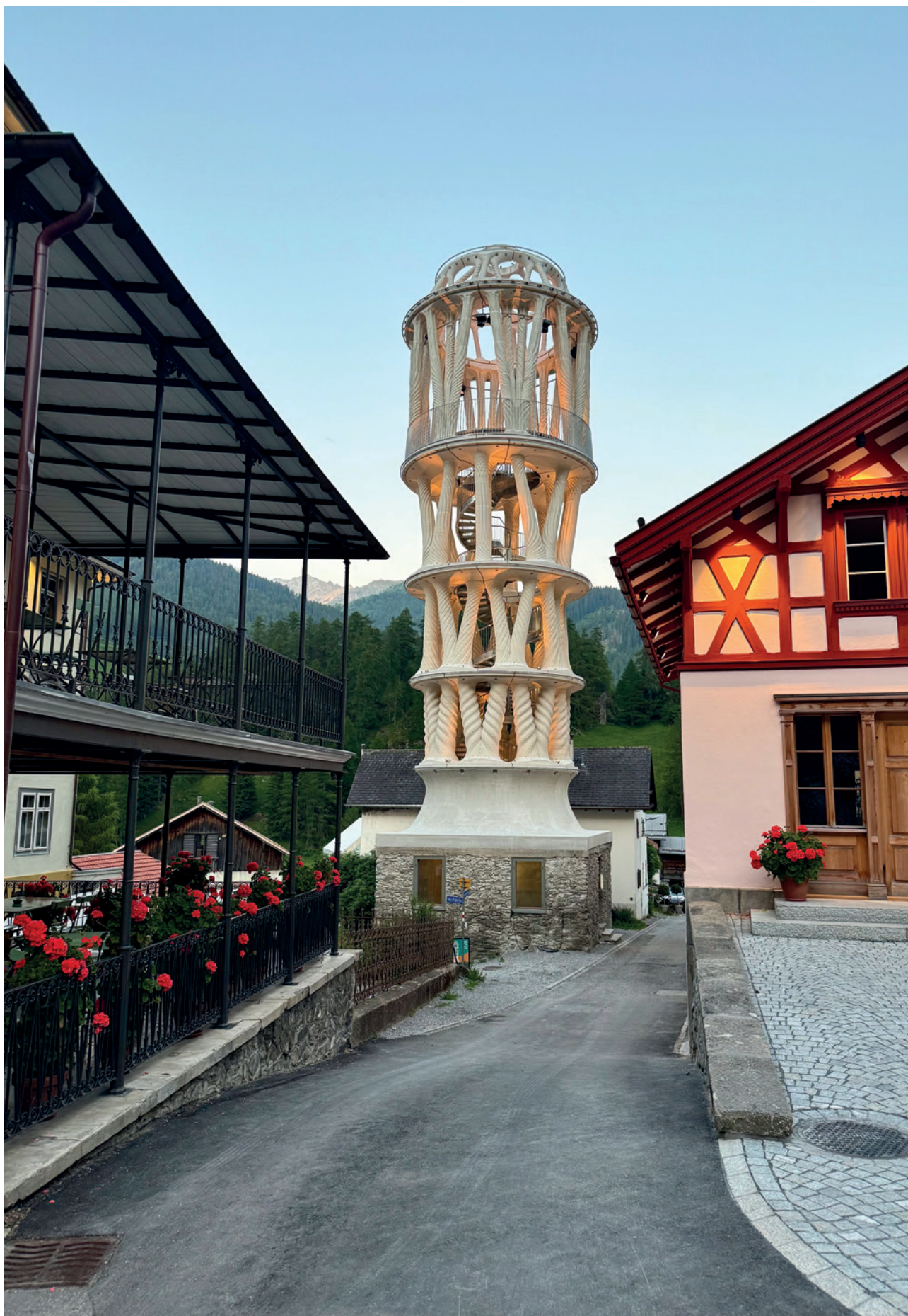
La Tour blanche de Mulegns dans les Grisons. La plus haute structure imprimée en 3D au monde. (DR)
