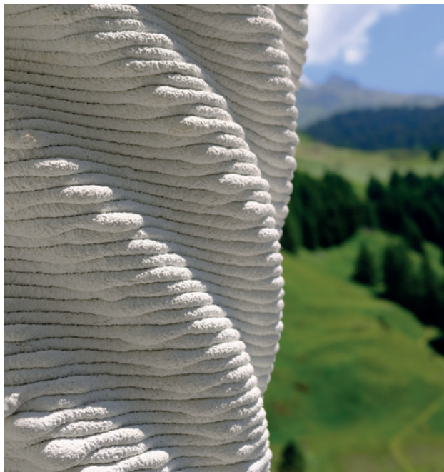
Un détail de la tour. Il montre bien les différentes strates créées par la machine. (DR)
