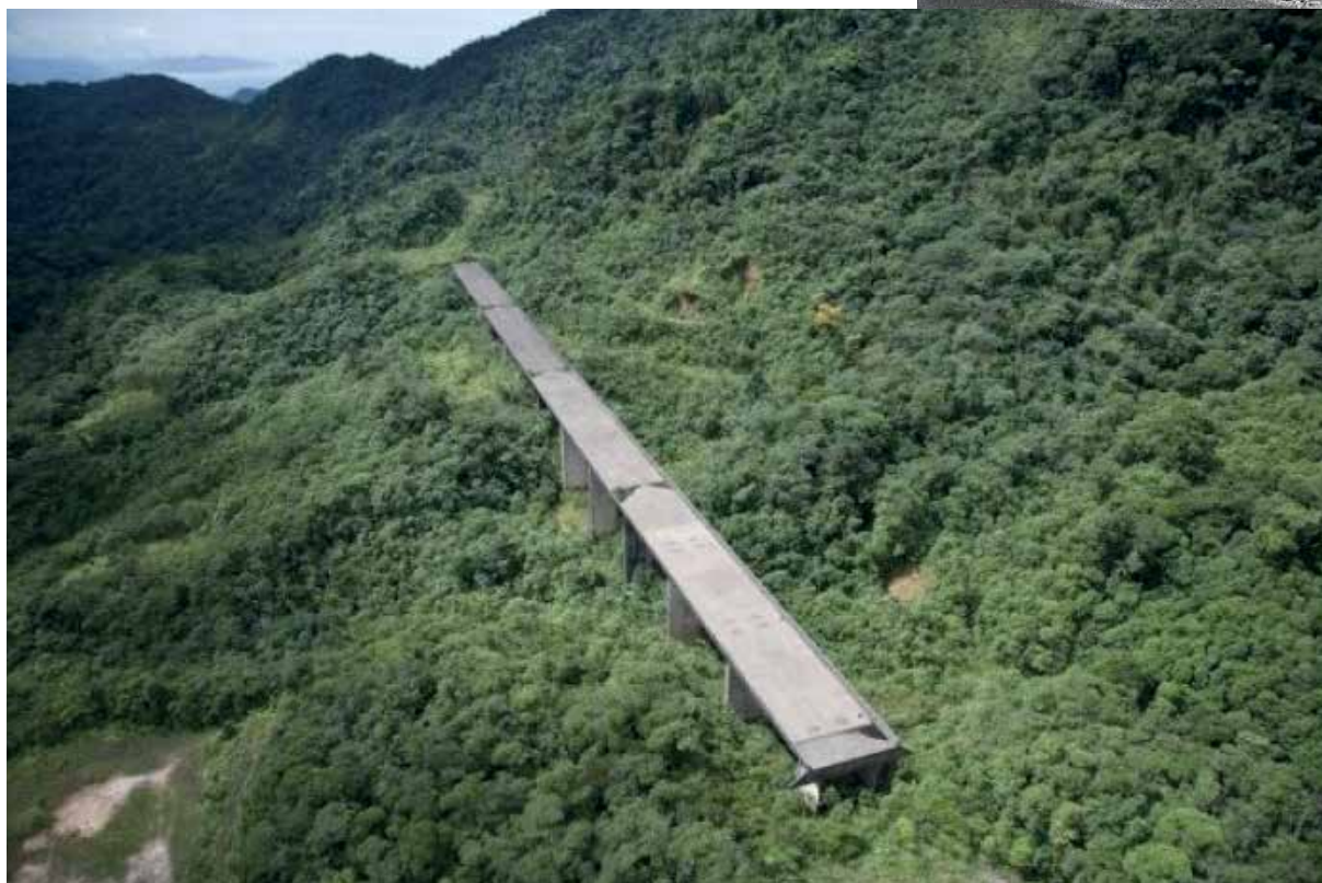
Le viaduc de Petrobras au Brésil, une langue de béton au milieu de la végétation. (DR)
