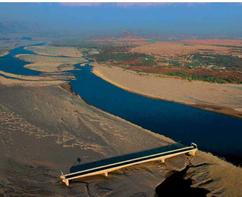
Le pont sur le Choluteca au Honduras ne sert plus à rien depuis que le cyclone Mitch a modifié le cours du fleuve. (DR)
