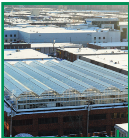
Montréal. Les serres sont sur le toit du bâtiment.
