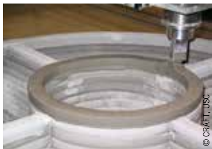
Fabrication 3D. Le robot, équipé d'un embout, dépose des couches de béton les unes sur les autres, à la manière d'une imprimante 3D.
