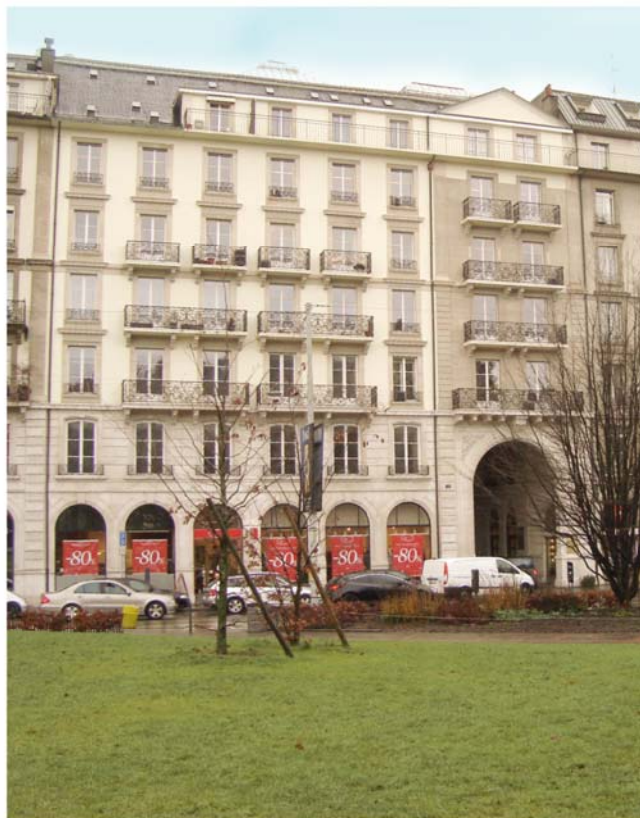
5. GENÈVE - RUE DES ALPES 9 – Beaux bureaux de 180 m 2 au 1 er étage traversant .Vue sur le square du Mont-Blanc et le jardin des Alpes. Très bel immeuble représentatif. Parking public à proximité. CHF 550.-/m 2 /an
