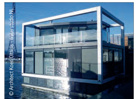
Citadel. Il s'agit du premier ensemble d'appartements flottants aux Pays-Bas, avec une façade recouverte de panneaux en aluminium.
