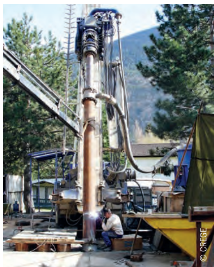
Forage de Brigerbad (VS) à 499 m. Ce dernier alimente les bains thermaux.
