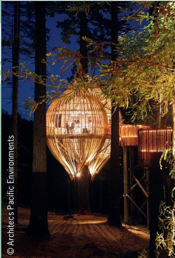
la structure a été réalisée avec des matériaux du cru – pin et peuplier lamellaire –, elle s'enroule autour du tronc auquel elle est fixée par des colliers en acier et elle est protégée par des panneaux transparents amovibles pour que la lumière puisse traverser ce joli coquillage de bois. On y monte, comme sur un bateau, par une passerelle, elle avance en pente douce sur plus de 60 mètres tel le long ruban d'un cerf-volant qui se serait posé sur la branche d'un arbre. ■
