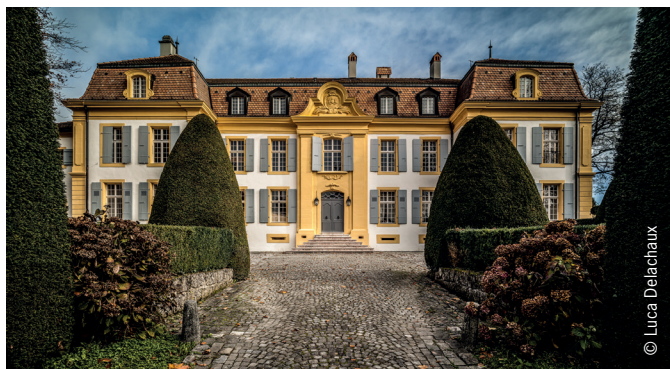
Clou rouge 2018. Le château de Cheseaux (VD) après restauration.
