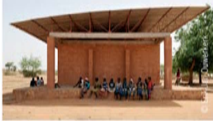
Première construction du «projet Gando». L'école primaire de Gando au Burkina Faso a été achevée en 2001. www.kere-architecture.com
